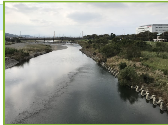
下流橋の架橋から80年以上が経ち、現在架け替え工事が進んでいる関戸橋より四谷方面を望む。
